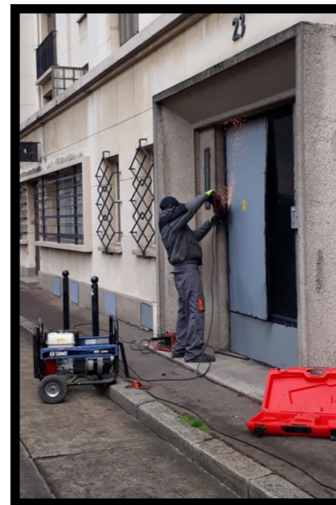
Dernière étape : les tôles soudées qui condamnaient l'accès avant la démolition de l'immeuble ont été déposées. Les locataires provisoires vont pouvoir s'installer.
