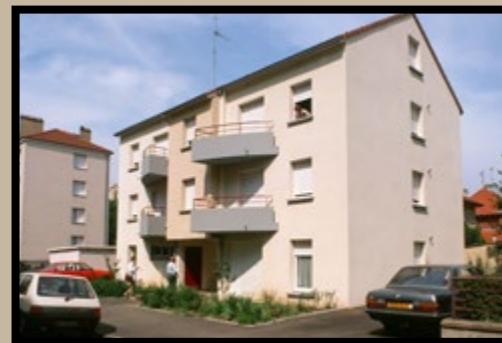
Construction à Thionville d'un immeuble avec logements d'insertion.
