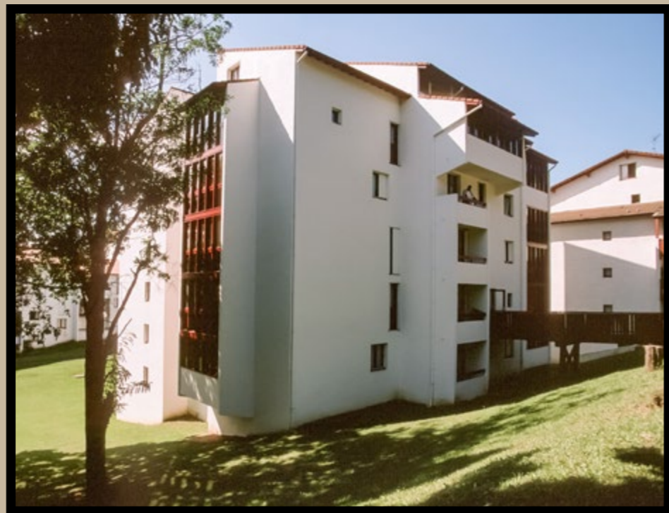
Construction de 39 logements à Hendaye.
