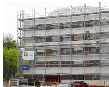
Ravalement de façade
