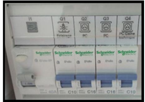
La deuxième ligne du tableau électrique commande la chaudière, les prises salle de bain.
