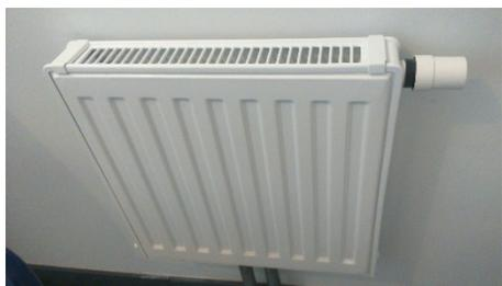
Chaque radiateur dispose d'une tête thermostatique ou d'un robinet simple réglable dans la salle de bain. Ils permettent de réguler la température au niveau de chacune des pièces.
