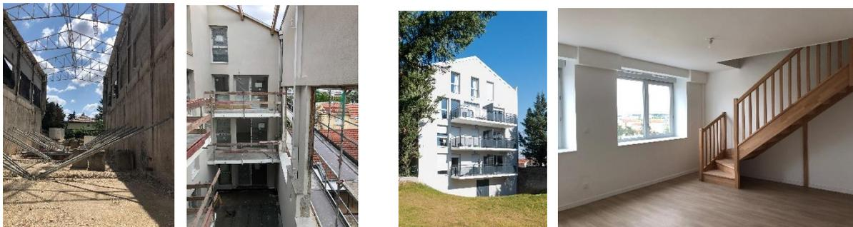
Butons provisoires de renfort de structure avant reconstruction des planchers et création du patio
