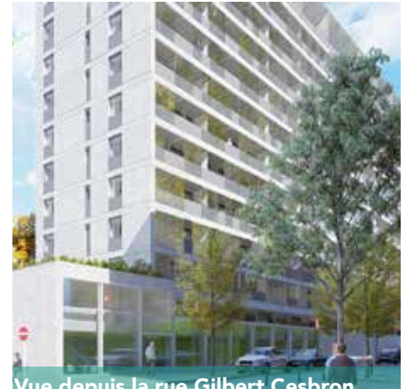
Vue depuis la rue Gilbert Cesbron
