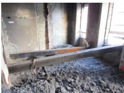
Curage et démolition des éléments de structure intérieurs (planchers, murs de refend), avec confortement de l'existant Remplacement des planchers et escalier bois par des planchers et escalier en béton armé
