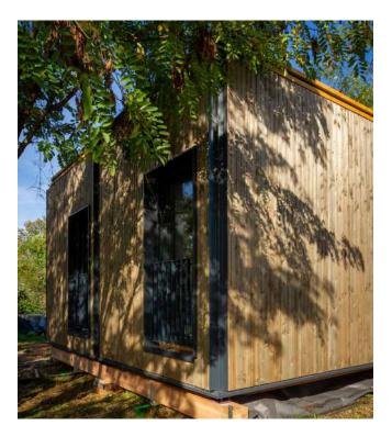
Les BMM sont constitués d'une structure en pin douglas de pays sourcé par SELVEA dans les Cévennes et certifié PEFC. Planchers, poteaux, murs et charpentes sont donc construits en ossature bois, une technique de construction qui allie solidité, légèreté et sobriété en matière première.
