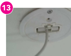
13 Enfoncer jusqu'à entendre un clic puis enfoncer le domino dans le plafonnier. Il ne faut donc pas ouvrir le plafonnier et en aucun cas le dévisser.
