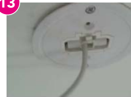
Enfoncer jusqu'à entendre un clic puis enfoncer le domino dans le plafonnier. Il ne faut donc pas ouvrir le plafonnier et en aucun cas le dévisser.
