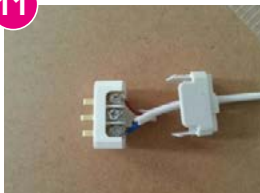
Visser les fils sur les extérieurs et la masse au milieu si besoin et reclipser les 2 parties ensembles
